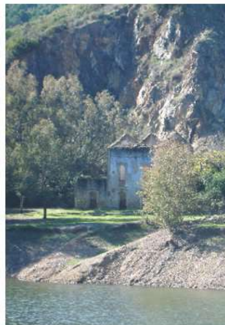
▲ Casa en ruinas frente a la llegada a la Ribera del Huelvo. / View of a house in ruins upon arrival to the bank of the River Huelva.
