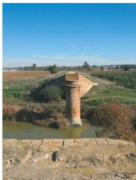
▲ Vistas desde el Puente ferroviario en ruinas sobre el río Guadiamar. Views of the Guadiamar river from the train bridge in ruins.
